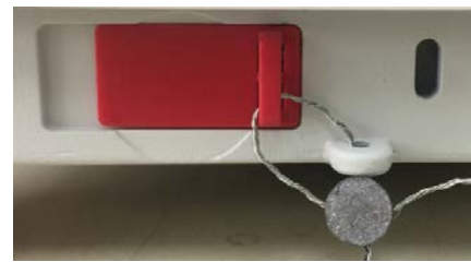
Bloqueado con cable de sellado
