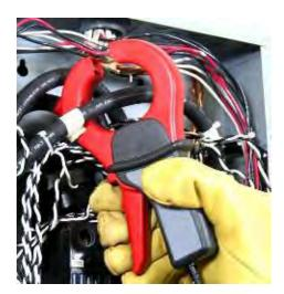
**Photo 2**: Install CT Around Conductor.
